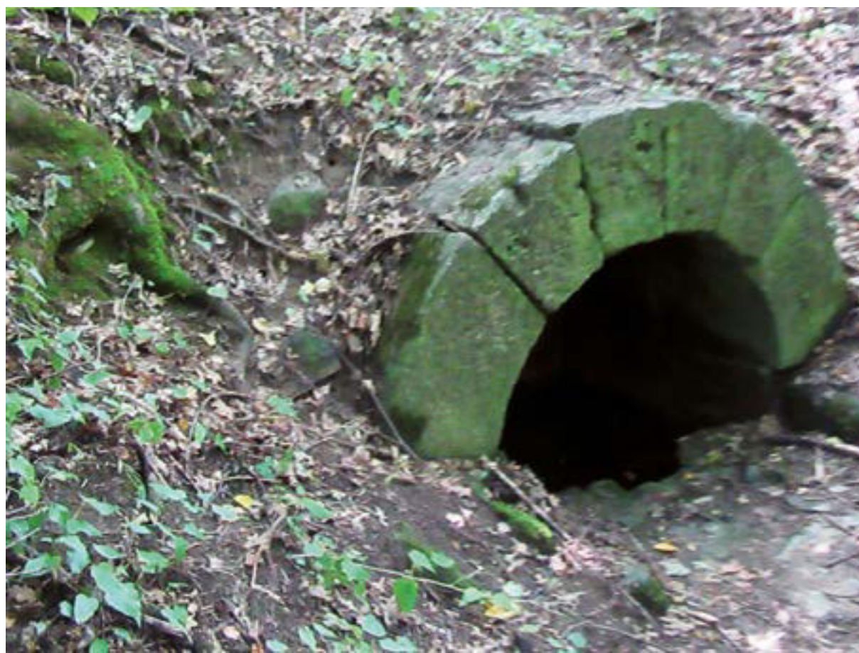
Die Quelfassung des Lützelbachs, ein rundbogiges Kalksteingewölbe, stammt aus dem späten Mittelalter und steht heute unter Denkmalschutz.
