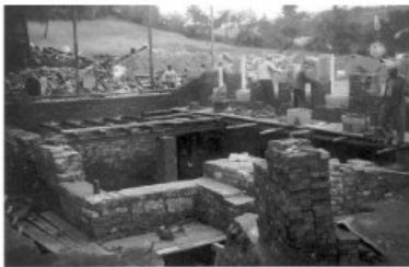
Maurerarbeiten an der neuen Kirche
