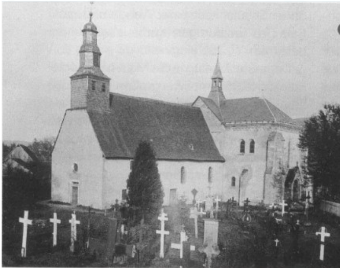
Dieses Foto um 1900 - bereits mit dem Erweiterungsbau, aber ohne Turm - verdeutlicht die ursprünglichen Ausmaße der Oberndorfer Kirche. Mehrere Erweiterungen der Neuzeit bewirkten, dass sie den Beinamen „Jossadom“ erhielt.
