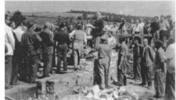
Auf den Trümmern des von deutschen Übungsbomben zerstörten Lettgenbrunn feierten die Neubewohner unter der Leitung von Landrat Kress 1947 den Beginn der Wiederbesiedlung mit der Grundsteinlegung für das erste Haus.
