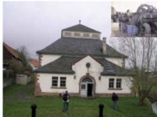
Das Wasserwerk von 1914 ist der technikgeschichtliche Höhepunkt in Mernes.
