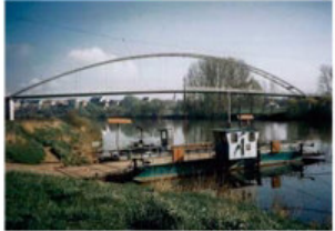
Über die Kilianusbrücke zwischen Dettingen und Mainflingen wird der Main ein zweites Mal überquert. Die Fährverbindung wurde mit dem Brückenbau eingestellt.
