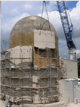
Das VAK Kahl ist weltweit das erste Kernkraftwerk das rückgebaut wird.
