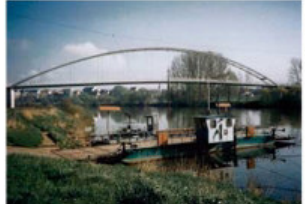
Über die Kilianusbrücke zwischen Dettingen und Mainflingen wird der Main ein zweites Mal überquert. Die Fährverbindung wurde mit dem Brückenbau eingestellt.
