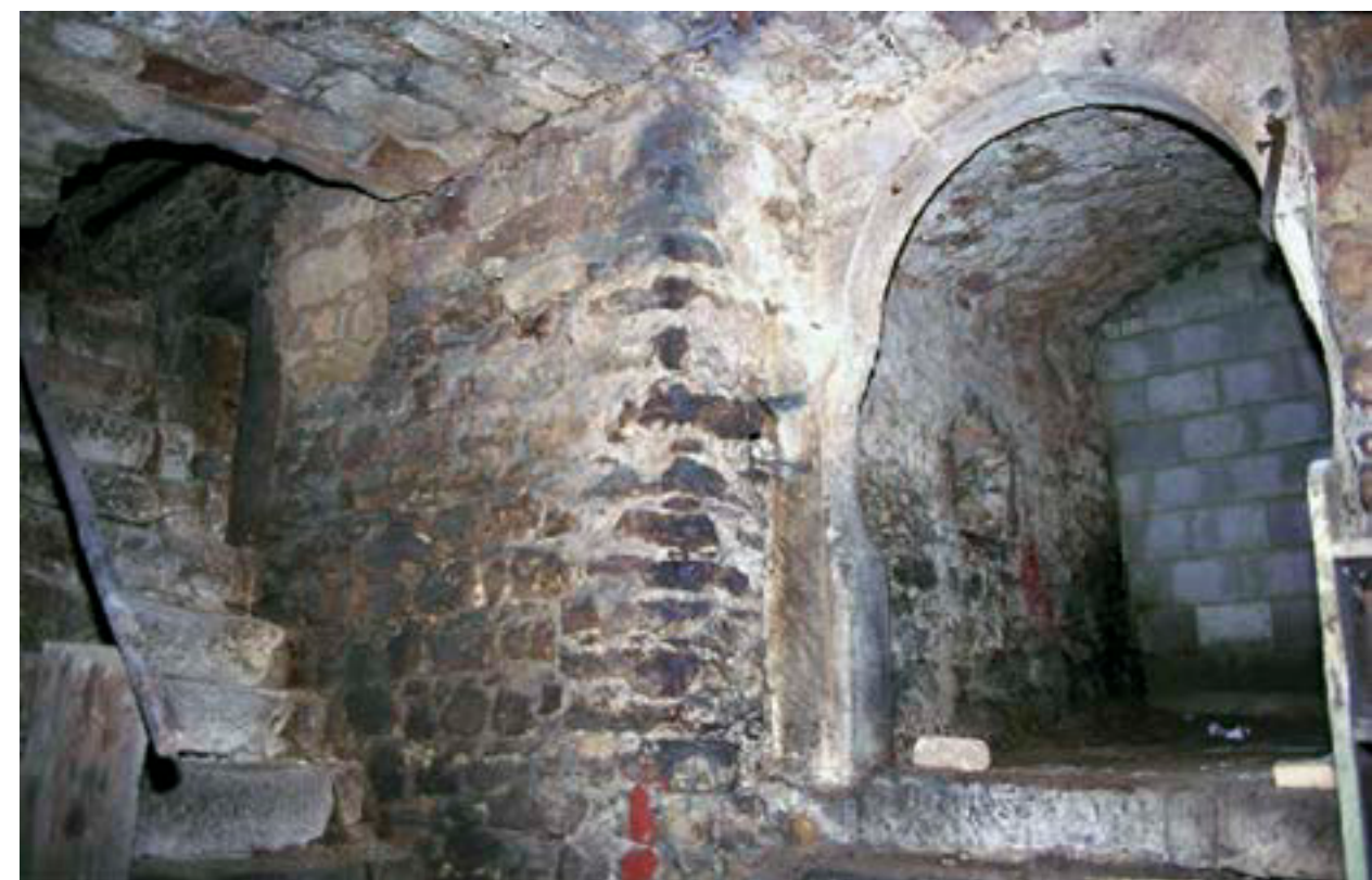
Keller des Templerhauses vor der Sanierung; rechts sichtbar der Beginn des unterirdischen Ganges in Richtung Kirche.
