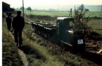
Ein kleines Bähnchen transportierte den Ton von der Grube in die Lagerhalle. Eine letzte Lore des Bähnchens ist in Eisenfeld neben der Dampfmaschine aufgestellt, die (sehenswert) am Ostermarkt sowie am Kirchweihmarkt am 2. Novembersonntag in Betrieb gesetzt wird.
