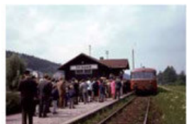
Wo sich heute eine Freizeitanlage befindet, hielt früher die Elsavatalbahn.
