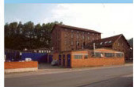
Die Schippacher Mühle (heute Maschinenfabrik Kotte) beherrscht das Ortsbild von Schippach.
