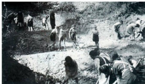
Foto von den Bauarbeiten an der Mariengrotte aus dem Jahr 1946.
