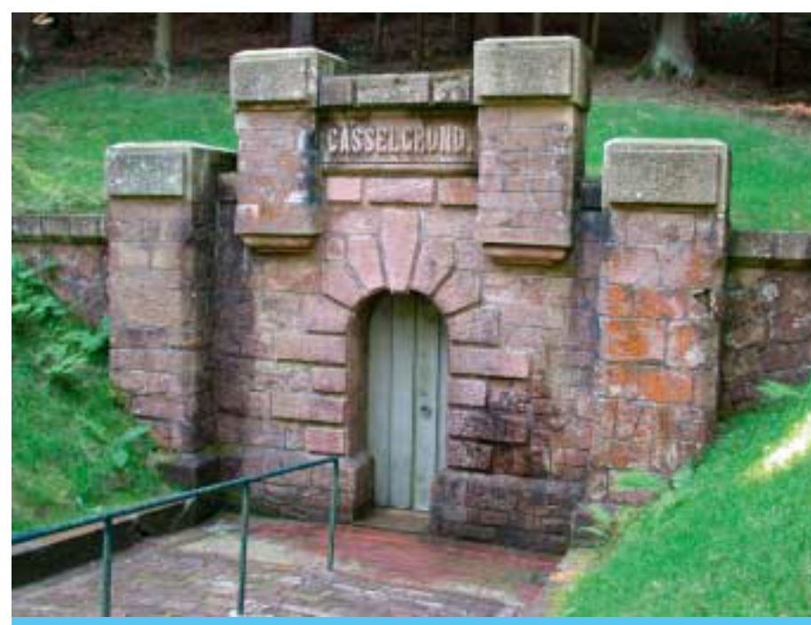
Eingang in den Stollen der Wasserleitung.
