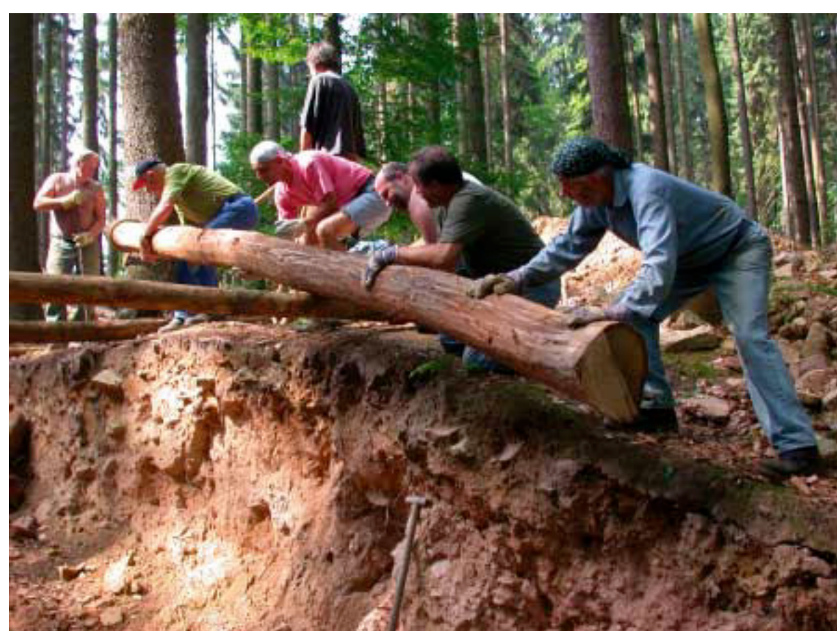
Viele Hände waren nötig, die Mauer der Altenburg abschnittsweise wieder herzustellen.
