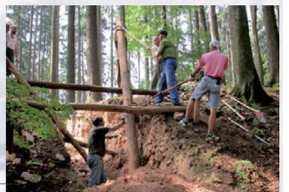
Die Holzkonstruktion für die Mauer wurde in traditioneller Weise ohne Maschinenunterstützung errichtet.
