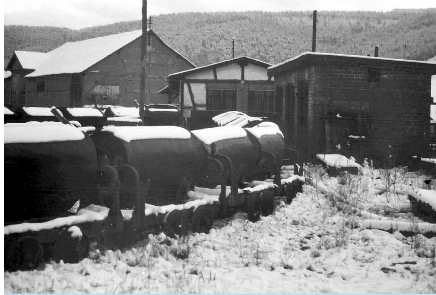
In der Bildmitte ist die Giebelseite des heute nicht mehr vorhandenen Lokschuppens zu sehen. Hier waren die beiden Benzolokomotiven untergebracht. Rechts daneben steht das Gebäude, in dem das Benzol für die Lokomotiven lagerte. Im Vordergrund sieht man einige der 77 Loren, die im Bertha-Stollen zur Streckenförderung eingesetzt wurden.
