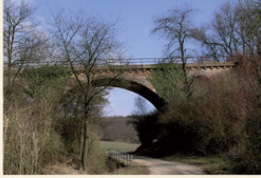
Die Bahnbrücke der Odenwaldbahn ist heute Kultur- und Naturschutzdenkmal.
