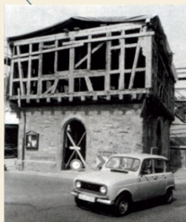
Das Dach des Pflaumheimer Rathauses wurde während der Renovierung abgetragen.
