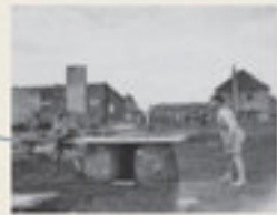
Der Aufbau (die Schürze ist bereits abgeris- set) mit ersten Siedern
