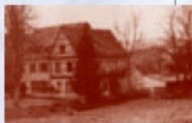
Eine der wenigen noch erhaltenen Schweinheimer Mühlen ist die Dämpelsmühle, die 1610 als Mühle »uff dem Schafsdümpel« erschein.
