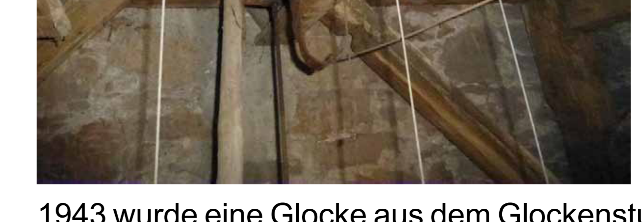
1943 wurde eine Glocke aus dem Glockenstuhl entfernt, die eingeschmolzen werden sollte. Zu diesem Zeitpunkt könnte diese Notlösung installiert worden sein.
