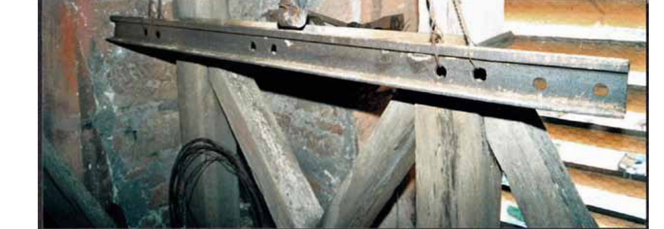
Glockenstuhl der Alten Kirche und die Aufhängung der Gewichtumlenkung
