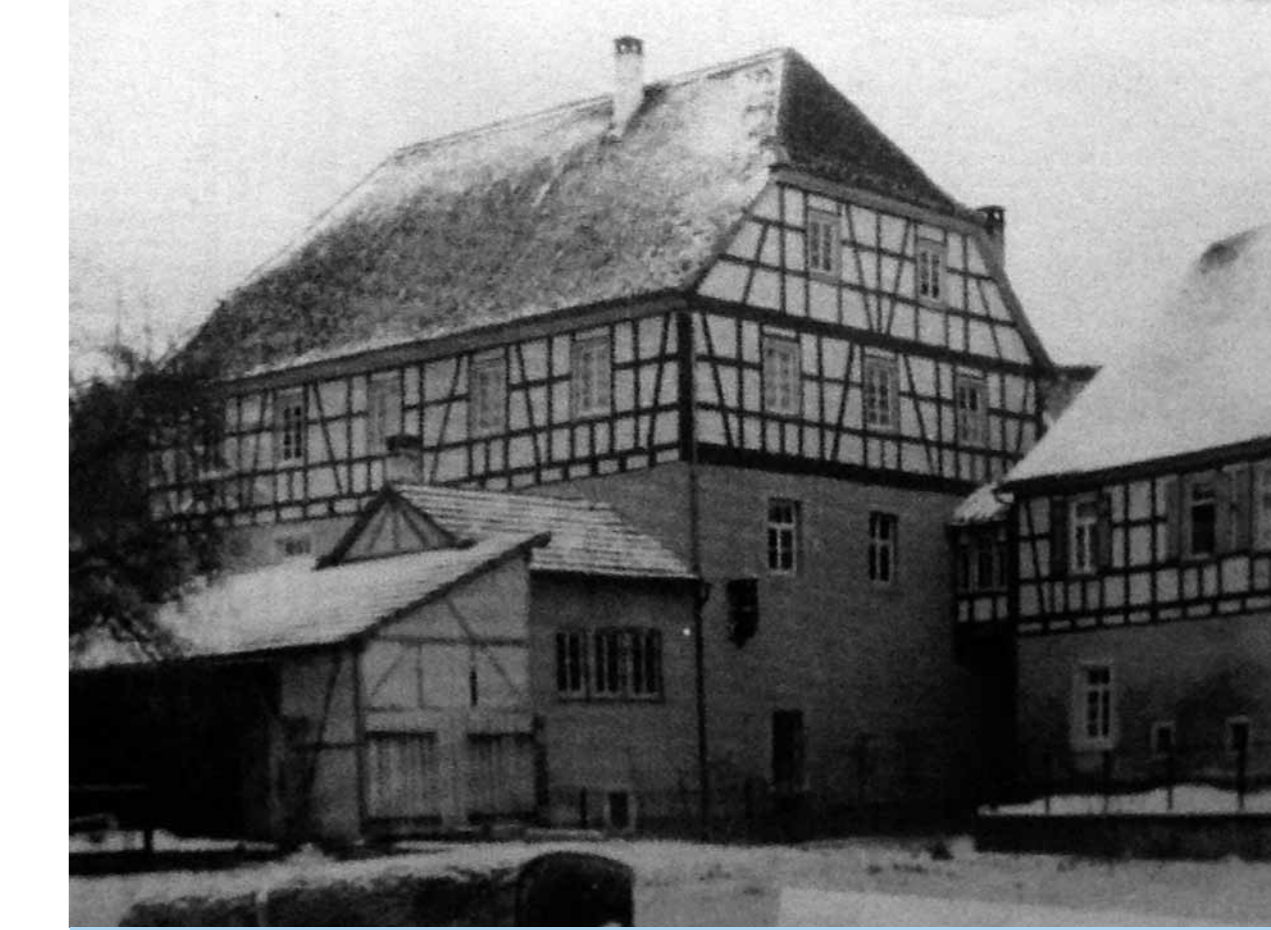
Das 1978 abgerissene Mühlengebäude - Foto unten mit Ansicht von der alten Schäftersheimer Straße
