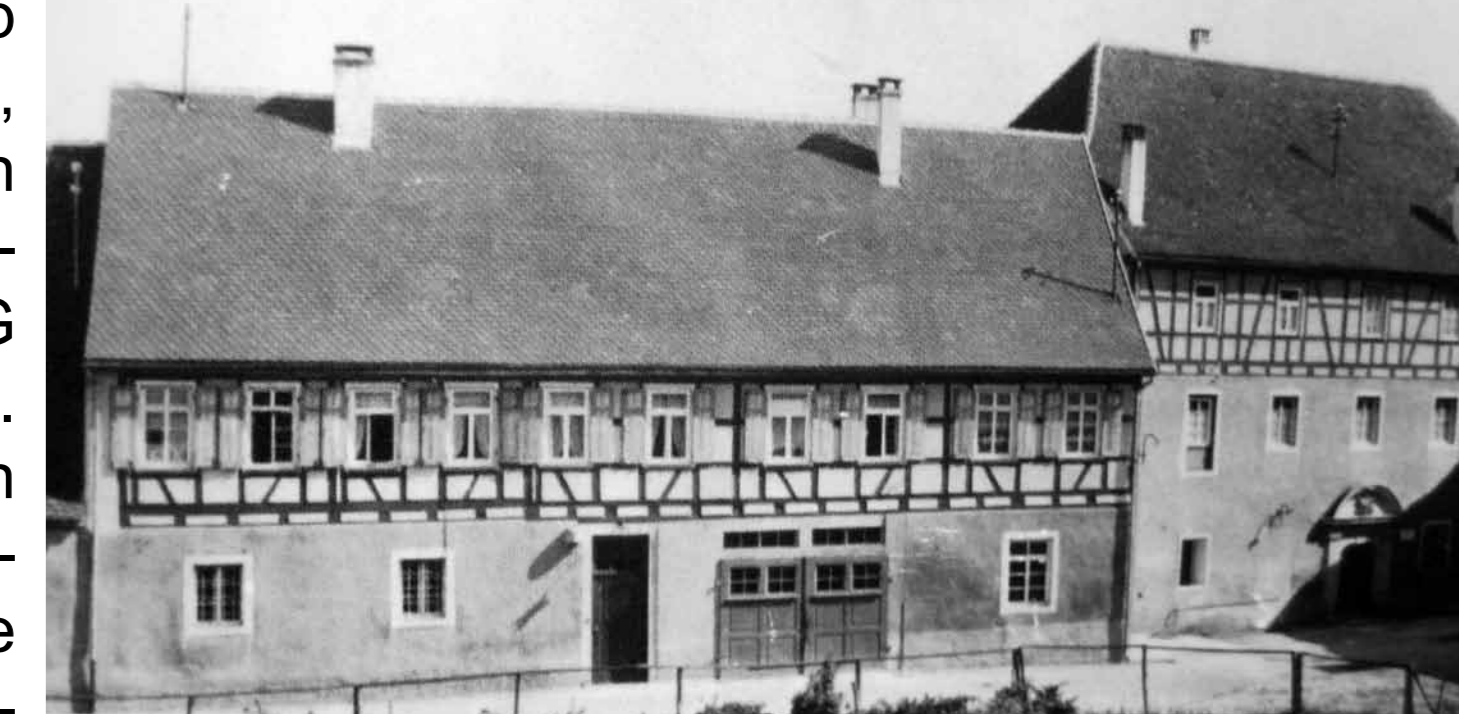
Nach Sanierung und Erweiterung unten der nostalgisch anmutende Verwaltungsbau
