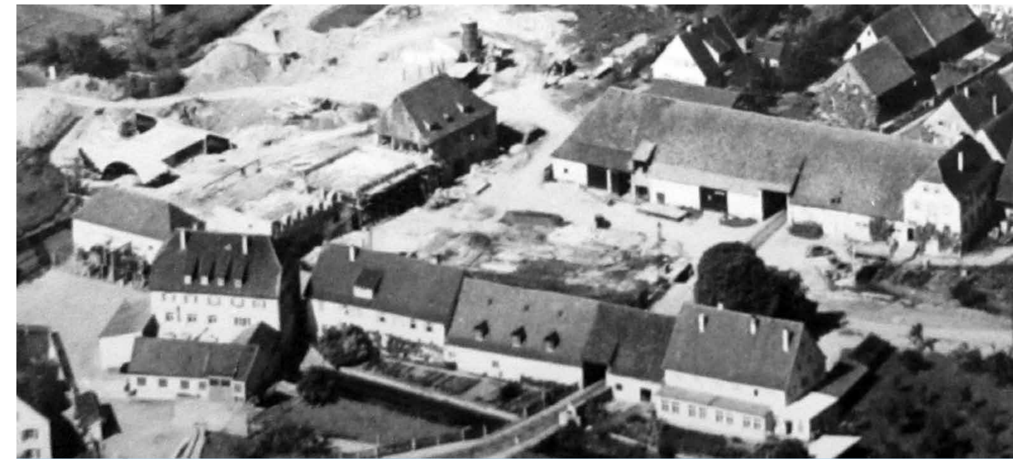
Luftbild der Baustelle mit dem niedergelegten „Langen Bau“ (links)
