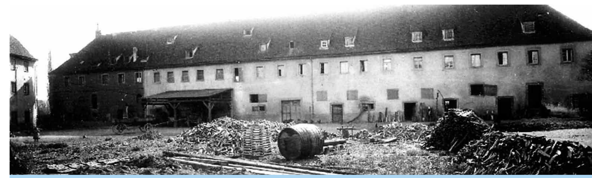
Der „Lange Bau“ vor dem Abriss und Wiederaufbau
