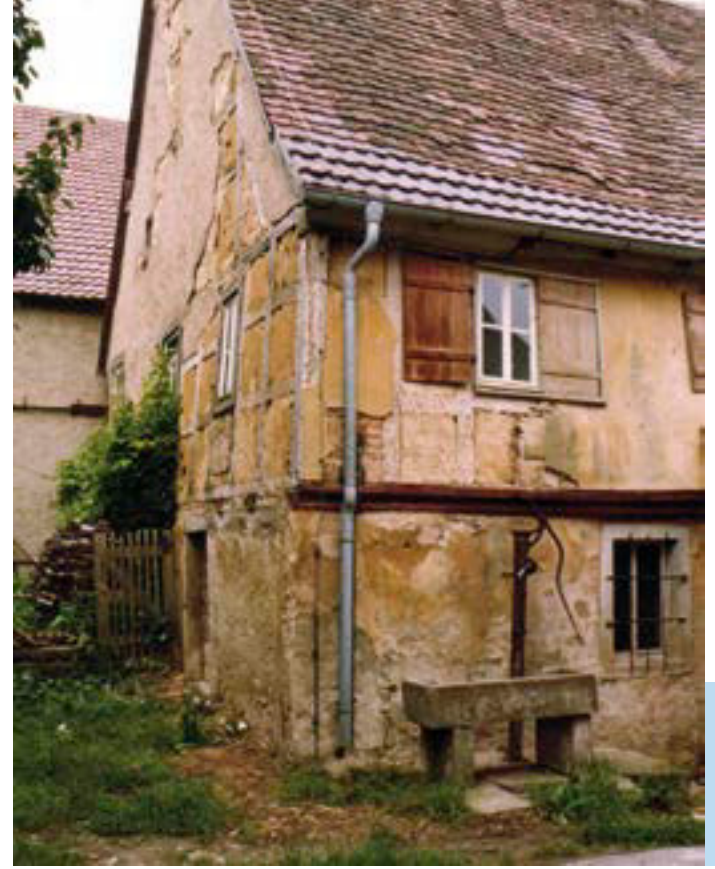
Das Rathaus vor der Renovierung im Jahre 1984. Es steht gegenüber der Infotafel.
