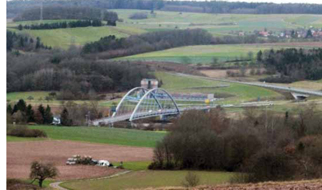
Blick auf die 2002 eröffnete Nordbrücke. Mit ihr wird die Innenstadt vom Verkehr entlastet und die Gewerbegebiete sind direkt mit dem Autobahnzubringer verbunden. Im Hintergrund rechts der Marktheidenfelder Stadtteil Marienbrunn.
