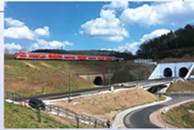
Alte und neue Trasse nebeneinander
