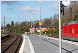
Bahnsteig in Laufach mit dem ehemaligen Lokschuppen im Hintergrund
