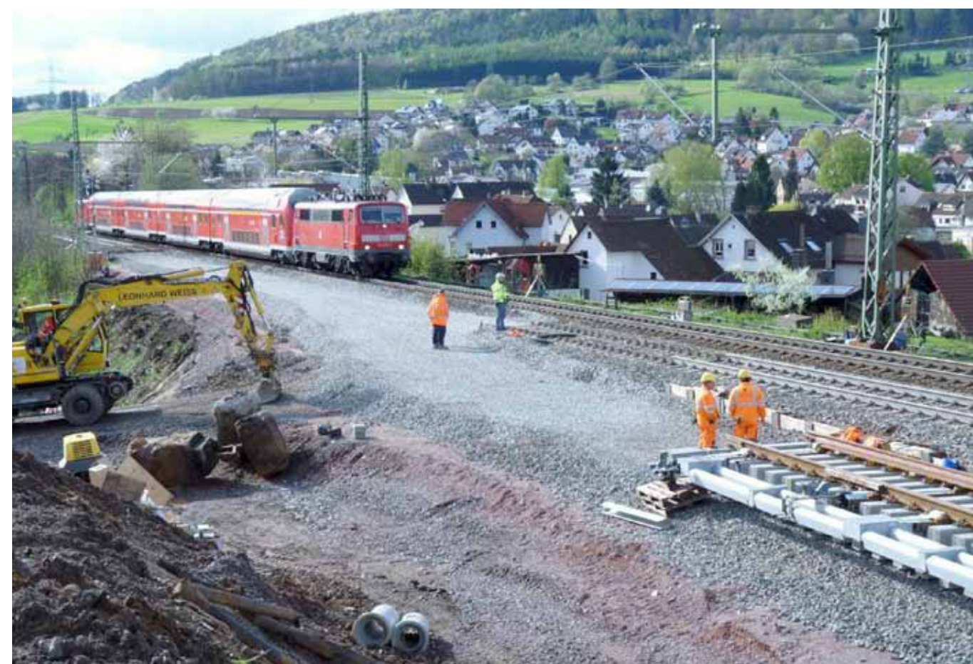
Regionalexpress auf der alten Strecke - die neuen Gleise werden parallel gelegt.
