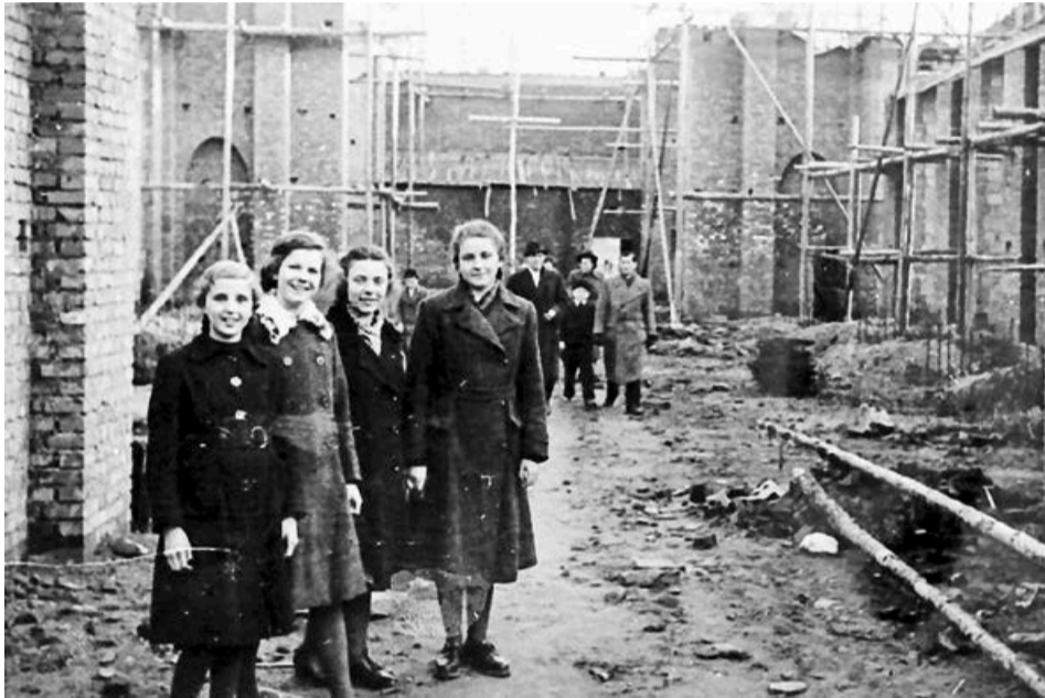
Das Begehen der Baustelle war damals möglich ...
