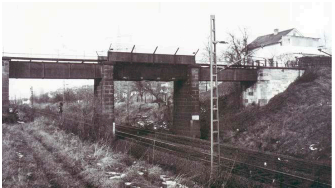
Die Brückenkonstruktion für den Steinbach über die Bahnlinie Frankfurt-Würzburg
