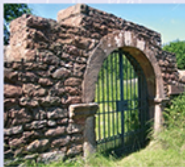
Das sanierte Eingangsportal zum Grubinger Kirchhof
