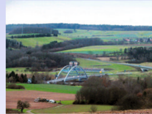
Die neue Marktheidenfelder Nordbrücke
