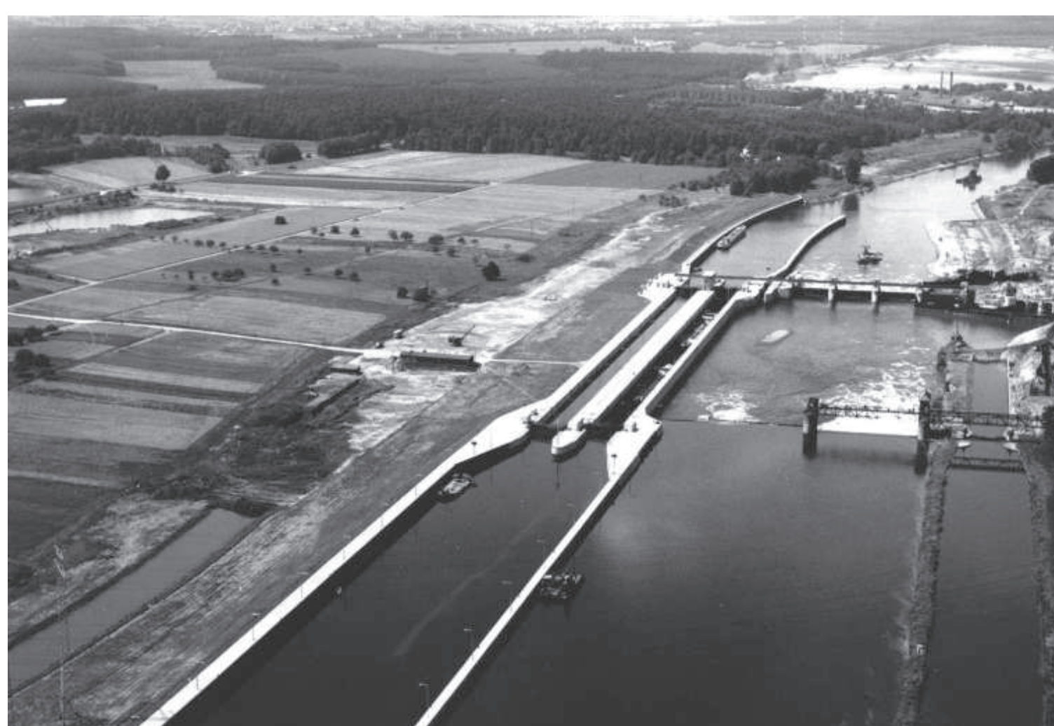
Die neue (zweite) Schleuse im Jahr 1970, rechts Rest der alten Schleuse
