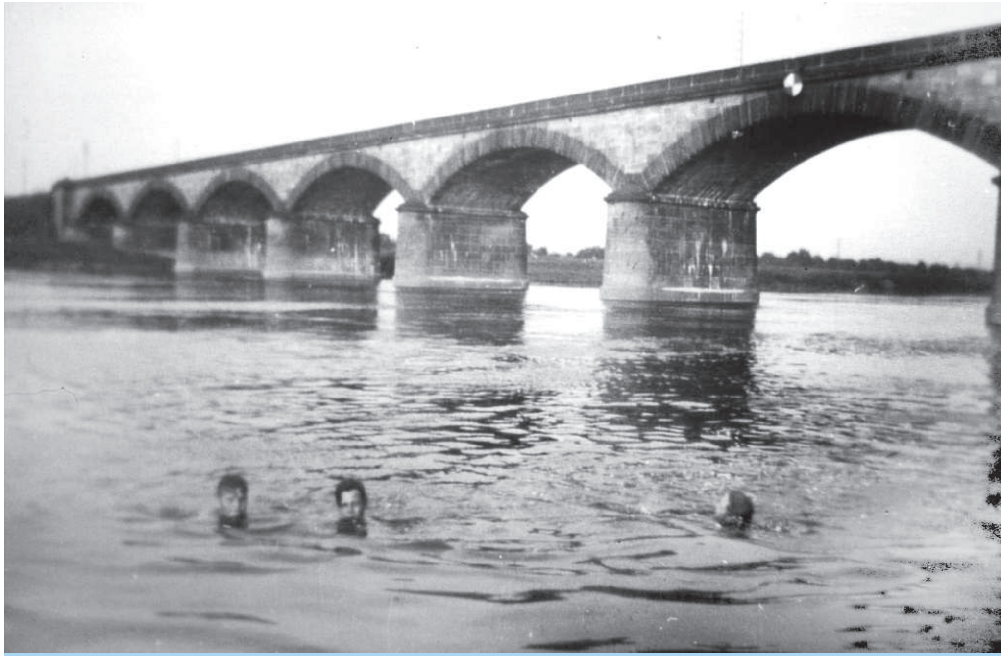
Die neunbogige Eisenbahnbrücke bei Stockstadt war ein Meisterstück der Ingenieurtechnik in der Mitte des 19. Jahrhunderts.
