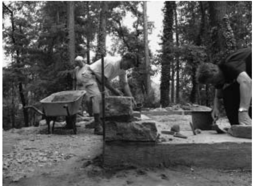
Die jetzt sichtbaren Fundamente des Wohnturms ruhen auf einem massiven Betonfundament.
