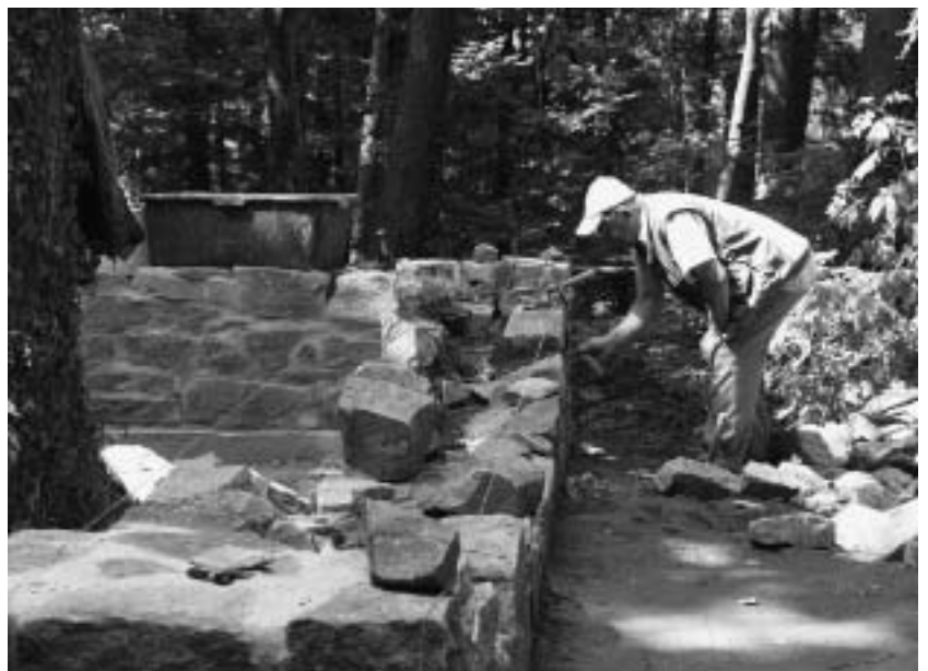
Schicht für Schicht schreitet das Werk voran. Dabei wird stets darauf geachtet, dass der Mauer genügend Zeit zum Austrocknen bleibt.
