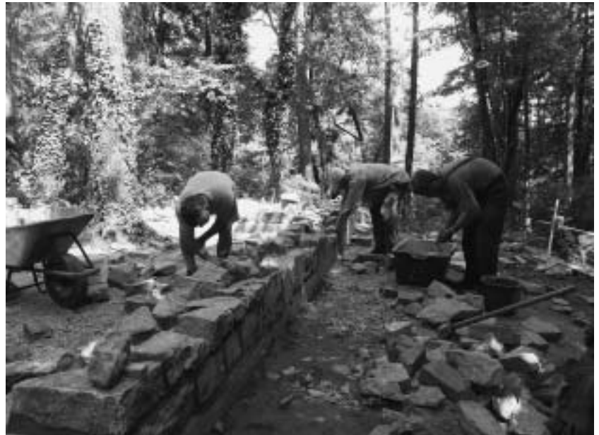
Das zweischalige Mauerwerk wurde in traditioneller Art und Weise hochgezogen.
