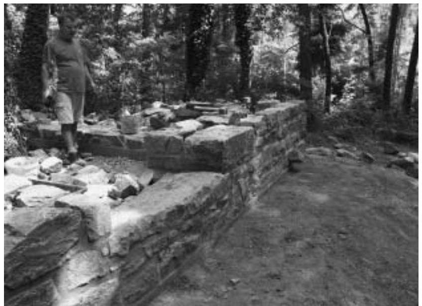
Die verworfene Sandsteinplatte, die in der Verfüllung der Torrampe lag, wurde als Türschwelle in die Rekonstruktion eingebaut.
