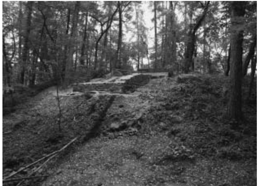
Die Rekonstruktion des Wohnturmfundaments und die neu aufgemauerte linke Torwange bestimmen fortan das Gesamtbild des Burgstalls in Haibach.
