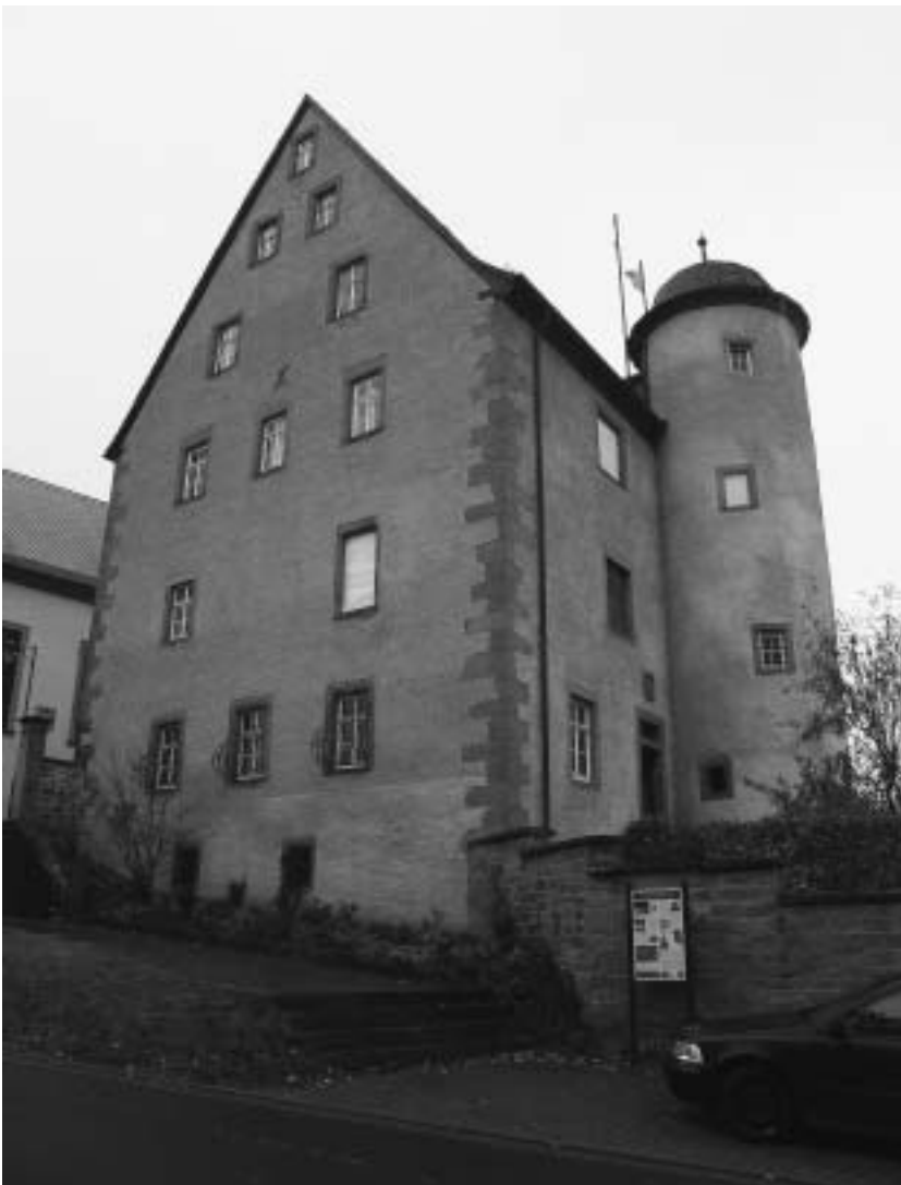
Das Schloss in Wiesen in seiner heutigen Form wurde am Ende des 16. Jahrhunderts errichtet.
