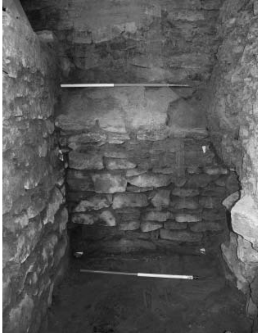
Bei baubegleitenden Untersuchungen im Inneren des Schlosses in Wiesen stieß man auf den ursprünglich überwölbten Keller eines Vorgängerbaus aus der Zeit um 1400.
