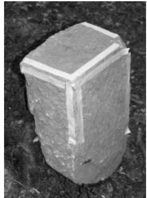
Die abgeklebten Kanten eines Sandsteins von der Ketzelsburg verdeutlichen, an welchen Seiten der Quader sorgfältig zugerichtet wurde.
