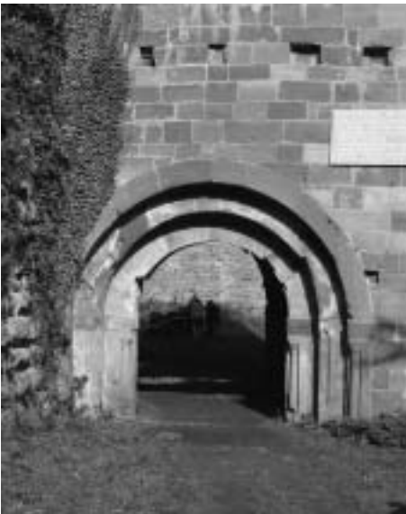
Sehr sorgfältig zugerichtete Sandsteine schmücken das Eingangsportal der um 1200 errichteten Burg Wildenberg im Odenwald.
