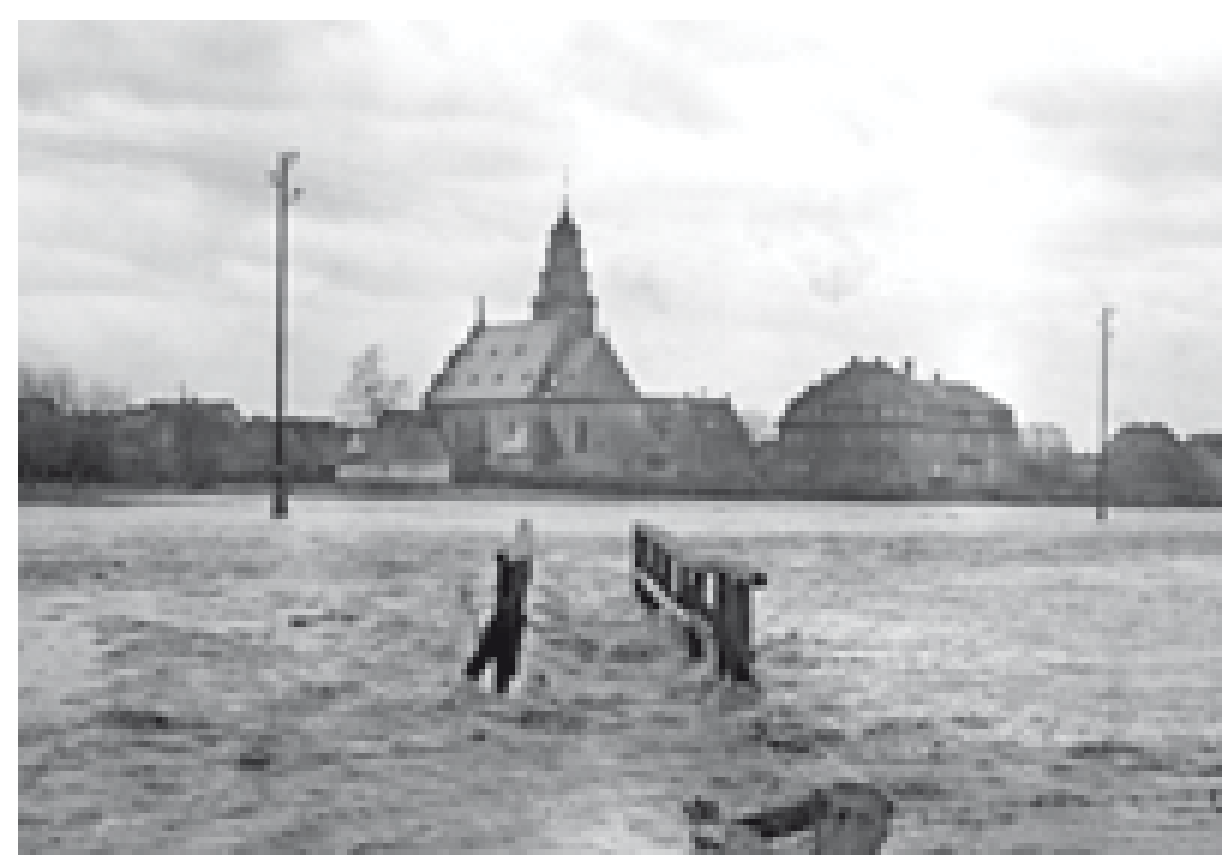
Hochwasser auf der Höhe der Sandmühle
