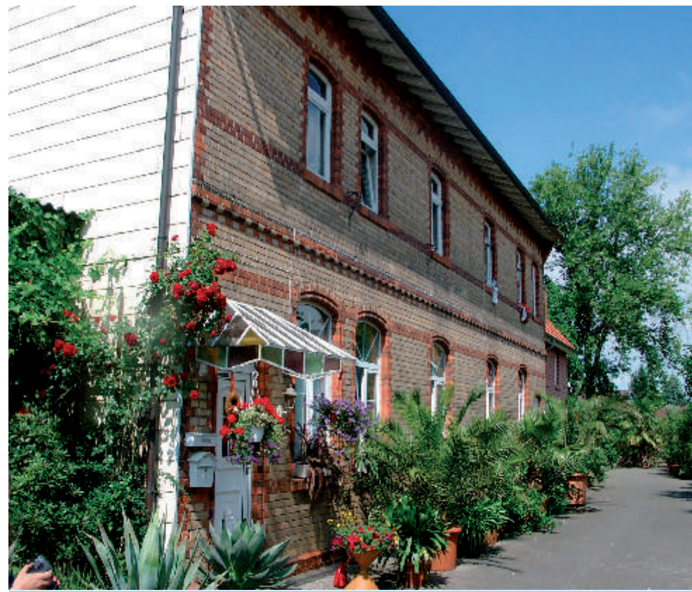
Die aus vor Ort hergestellten Tonziegeln errichtete ehemalige Zigarrenfabrik in Neuenhaßlau.
