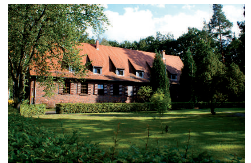
Gebäude des früheren Tanklagers in Neuenhaßlau
