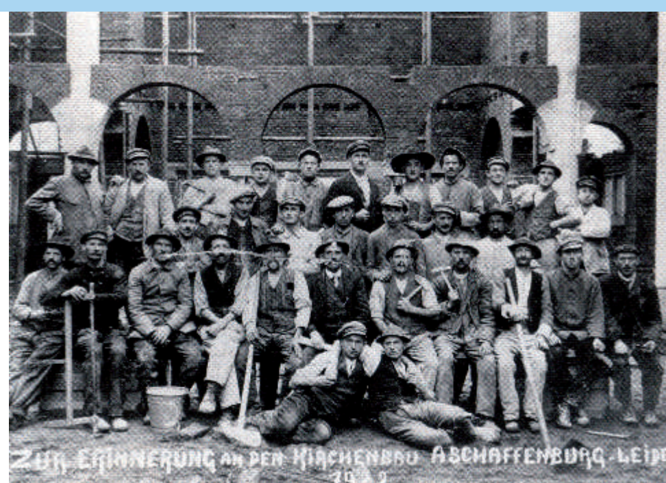
Fotografie während der Bauzeit der Laurentiuskirche. Ohne zahlreiche Geld- und Materialspenden sowie die unzähligen kostenlosen Kiesfuhrten Leiderer Fuhrleute hätte der Bau nicht vollendet werden können.
