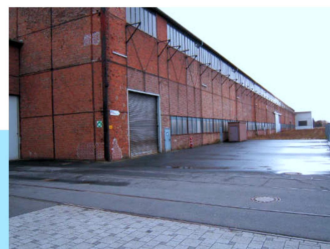
Die ehemaligen Werkshallen von Seibert wurden in das Industriegelände von Nilkheim integriert und werden heute von mehreren Firmen genutzt. Das Gelände befindet sich nach der Ampel nach ca. 200 m links des nun folgenden Abschnitts des Kulturweges.
