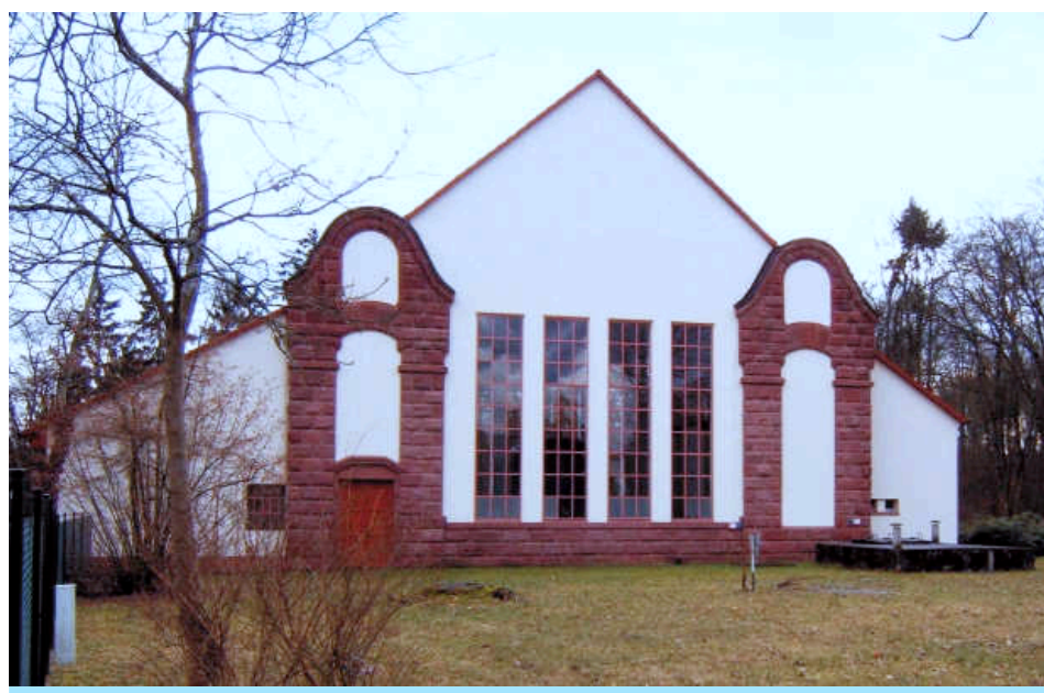
Wasserversorgung gestern und heute: Das alte und das neue Wasserwerk stehen dicht beieinander. Seit dem Jahr 2000 ist die neue Trinkwasser-Aufbereitungsanlage in Betrieb. Die Wasserwerke und das Rondell sind Bestandteil der Route der Industriekultur Rhein-Main.
