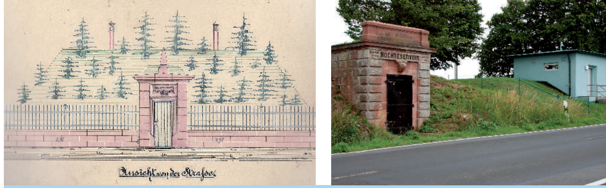
Der Michelriether Hochbehälter an der Esselbacher Straße – Plan und Ausführung, daneben der neue Hochbehälter
