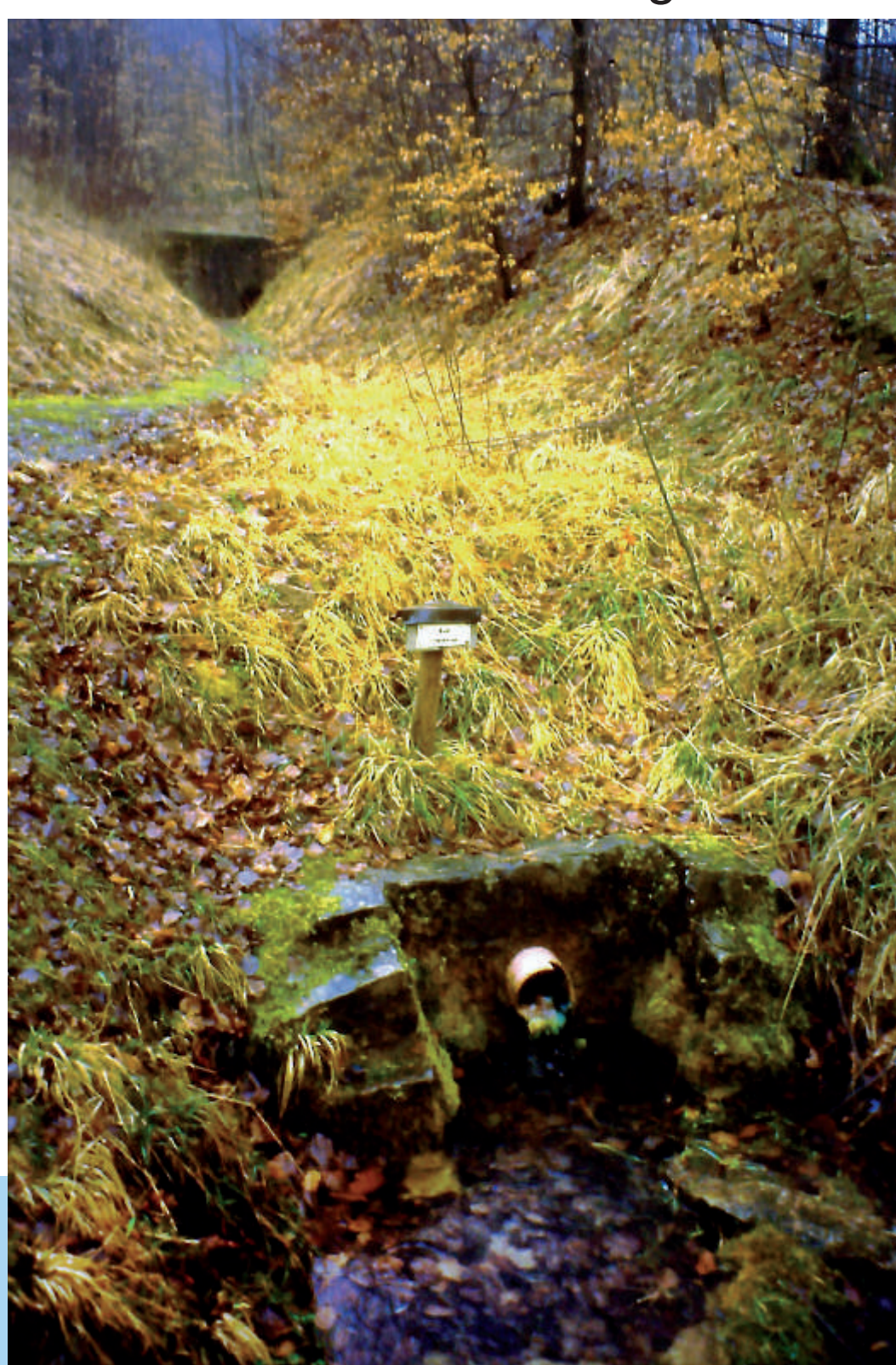
Von der Brunnenstube läuft das Wasser auf den ersten Metern in einer Röhre unterhalb des Pfades.
