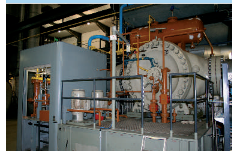
Oben: Einer der Rimparer Gasverdichter Mitte: Blick in das Innere der Anlage
