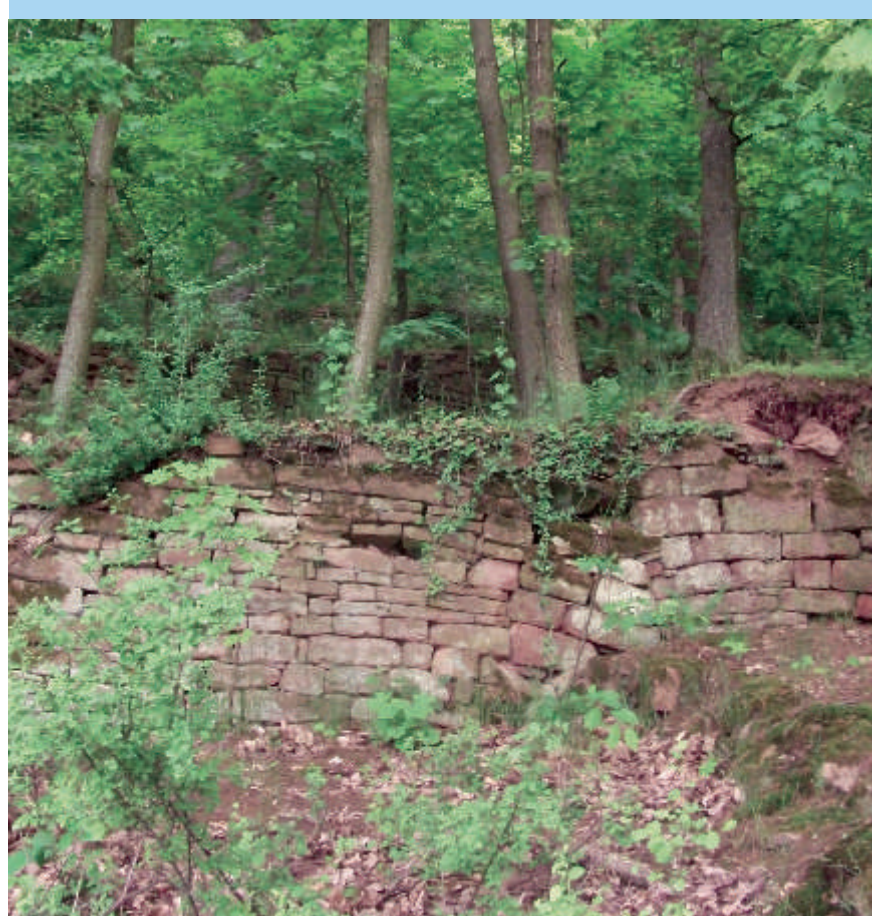
Am Gelnhäuser Sonnenhang sind auf weiten Strecken die Weinbergsmauern zu sehen. Durch den über 100 Jahre andauernden Bewuchs mit Bäumen sind die Mauertrassen inzwischen in großen Teilen beschädigt und vielfach umgestürzt. Im Hinblick auf die oberhalb der Stadt im steilen Abhang vorhandene Erosionsgefahr benötigen die Mauern Pflege.
