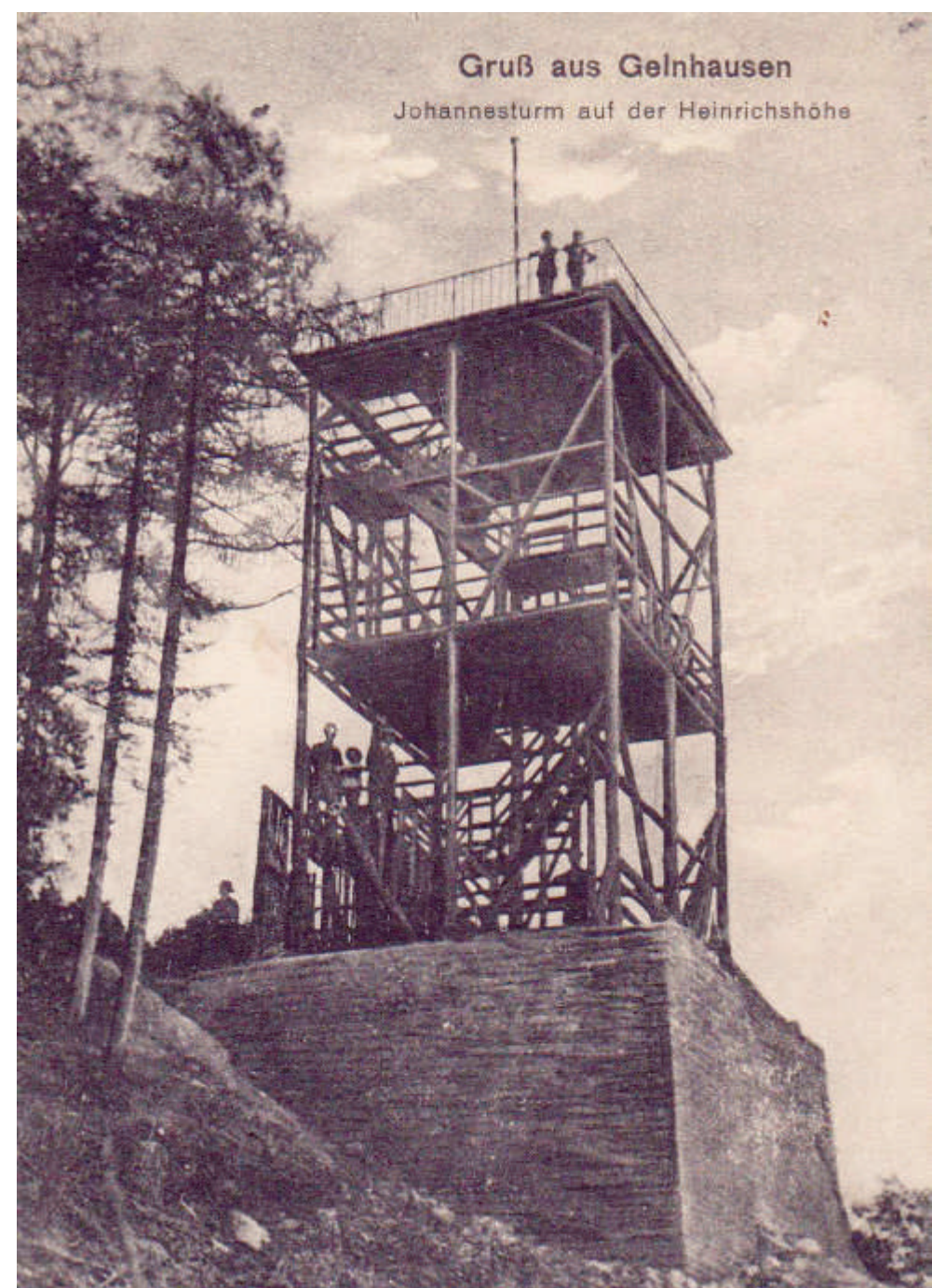
Der Aussichtsturm auf der Heinrichshöhe war aus Holz gefertigt und wurde später aufgrund von Witterungsschäden wieder abgetragen. Unten: Anzeige zur Übergabe des Turms auf der Heinrichshöhe
