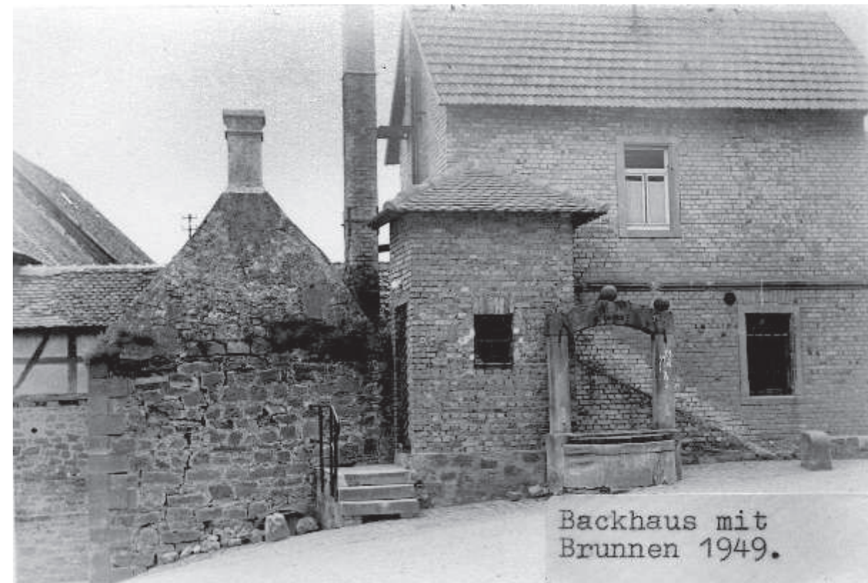
Der in typischer Bauweise errichtete Ofen des Backhauses ist der kleine Bau links mit Kamin.
