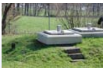
Am Mainufer befinden sich die Trinkwasserbrunnen.
